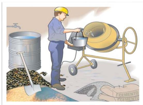
El agua utilizada para elaborar el hormigón permite hidratar, aglomerar y unir al cemento con los agregados.
